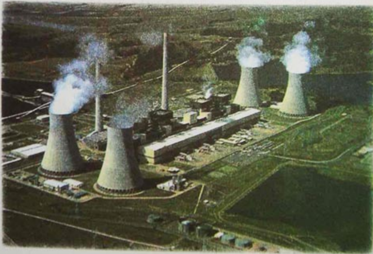
محطة نووية لتوليد الطاقة الكهربائية
